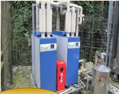
給湯ボイラー
